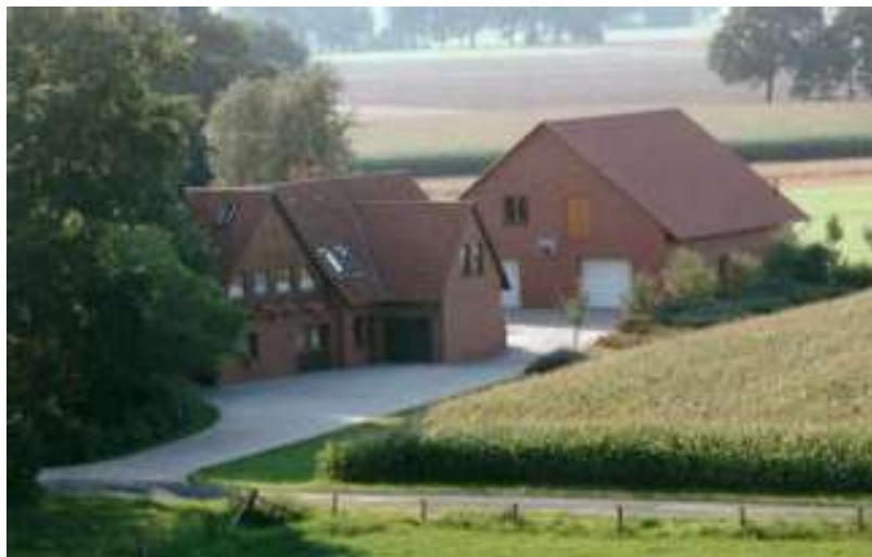
1995 – Das neue Betriebsgebäude
